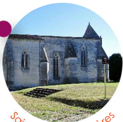
Saint-Palais à Verrières
