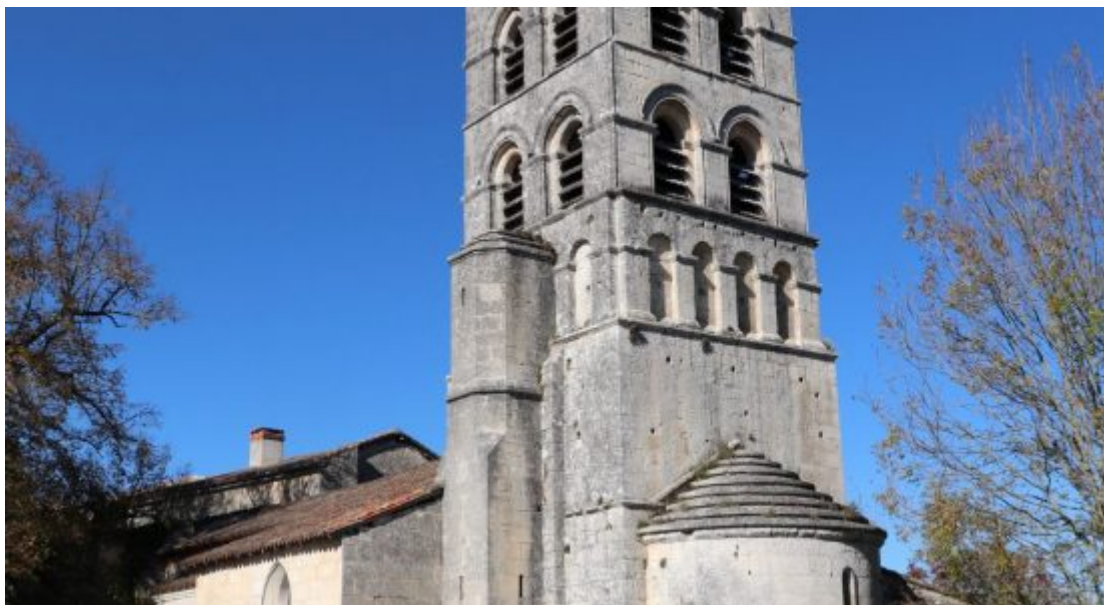
Eglise St Pierre à Sers
