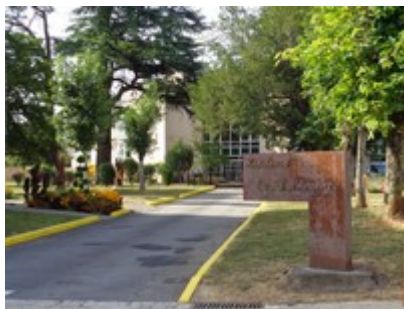
MAISON RETRAITE CHASSENEUIL
